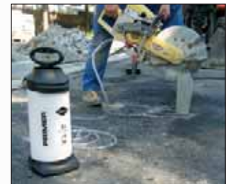
Trennschleifen im Straßenbau
